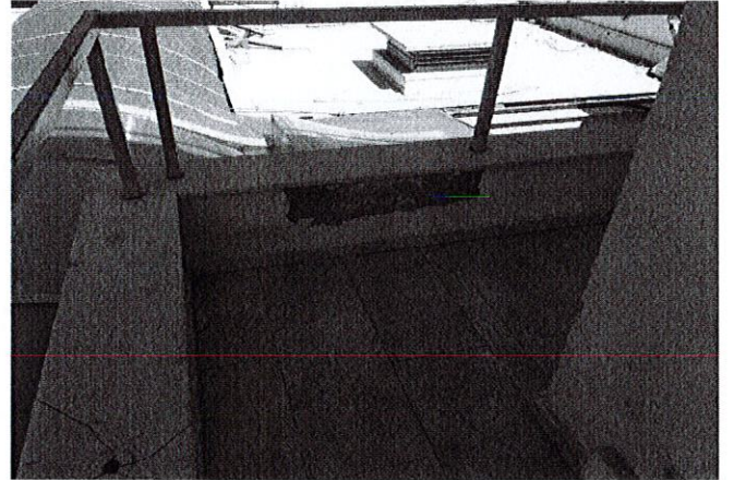
3.2. Çamaşırhane, WC ve Duş Kısımında Eski deforme olan tavan ve sıvaları gösterir örnek resimler
