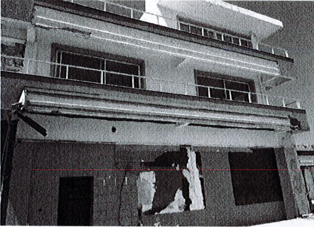
3.2. Çamaşırhane, WC ve Duş Kısımında Eski deforme olan tavan ve sıvaları gösterir örnek resimler
